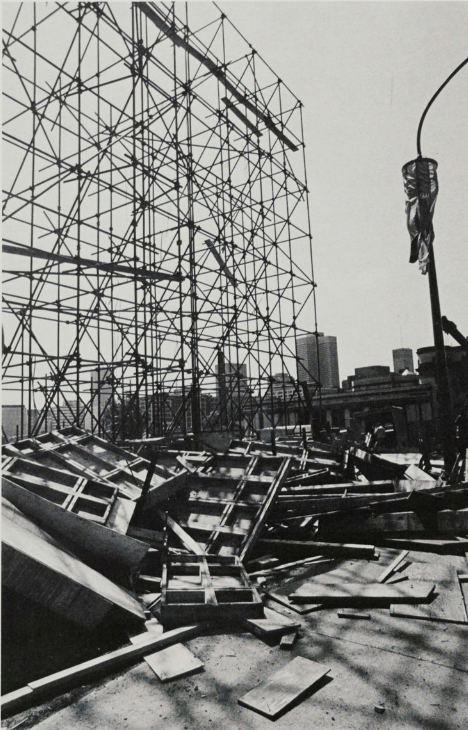
Démolition de l'oeuvre Les Maisons de la rue Sherbrooke , par les autorités municipales de la ville de Montréal, le 13 et 14 juillet 1976.
