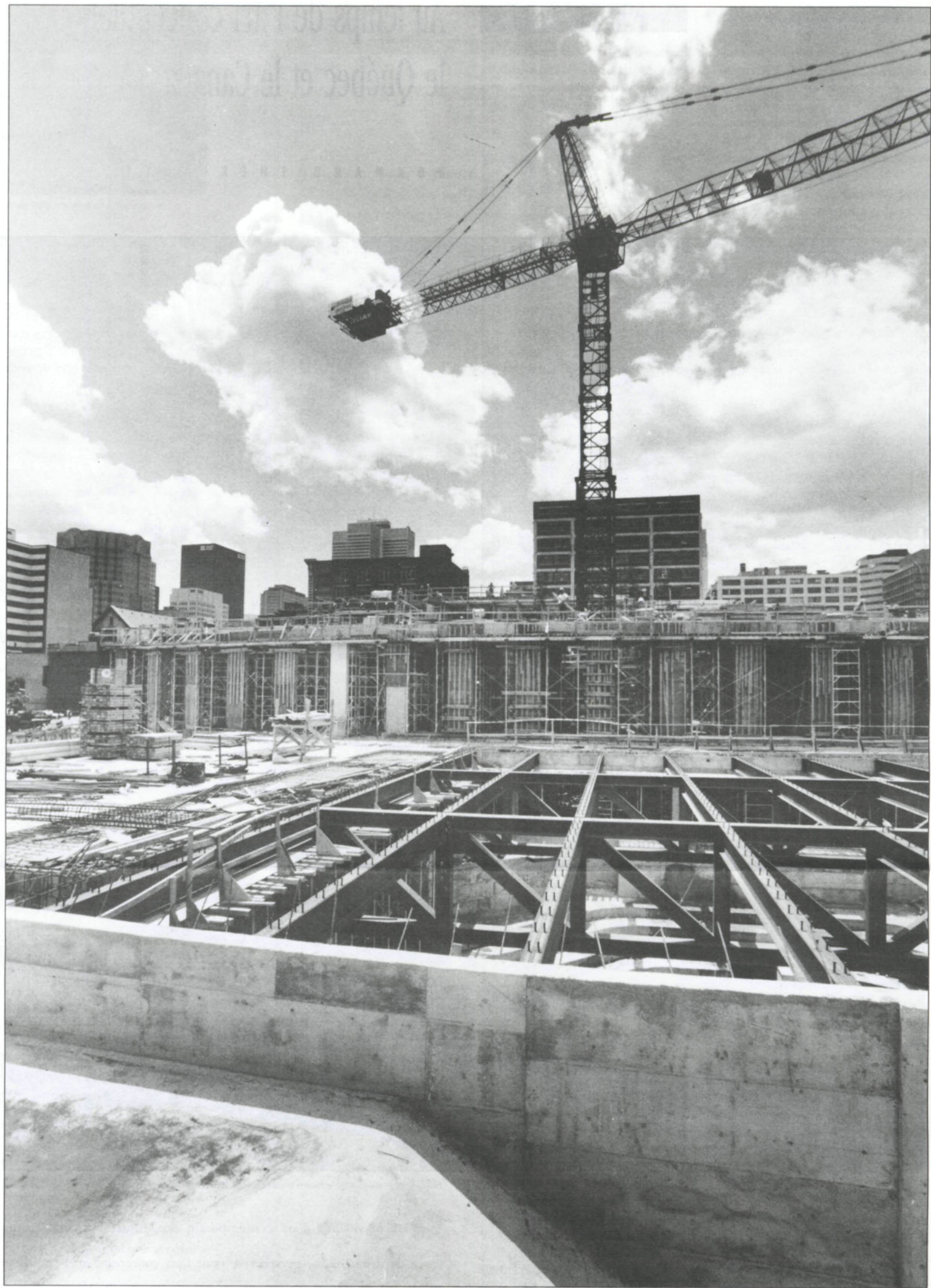
Chantier de construction, le 10 juillet 1990. Photo: Denis Farley.
